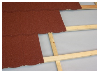
in verband installeren
