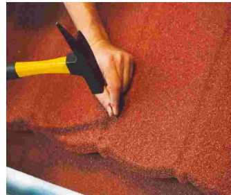
dakpanelementen boven de goot nagelen
