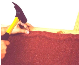
dakpanelementen onder de nok nagelen
